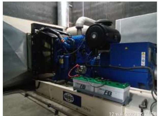
รูปที่ 2.19 เครื่องกำเนิดไฟฟ้าฉุกเฉิน
